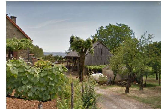
Ancien hangar agricole
