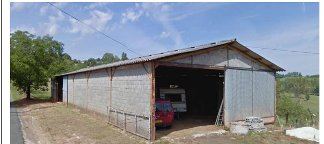
Ancien hangar agricole
