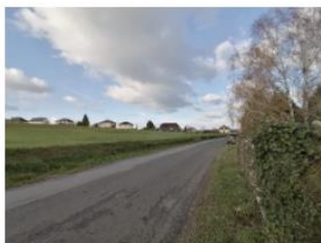
Route de Louignac après les travaux d'enfouissement
