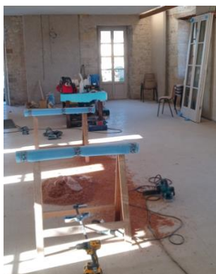
Remplacement des ouvertures
